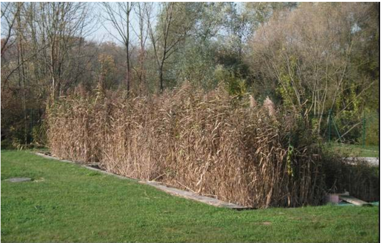
Abbildung 8 Bodenfilter BF1, BF2 (und BF3) im Oktober 2005
