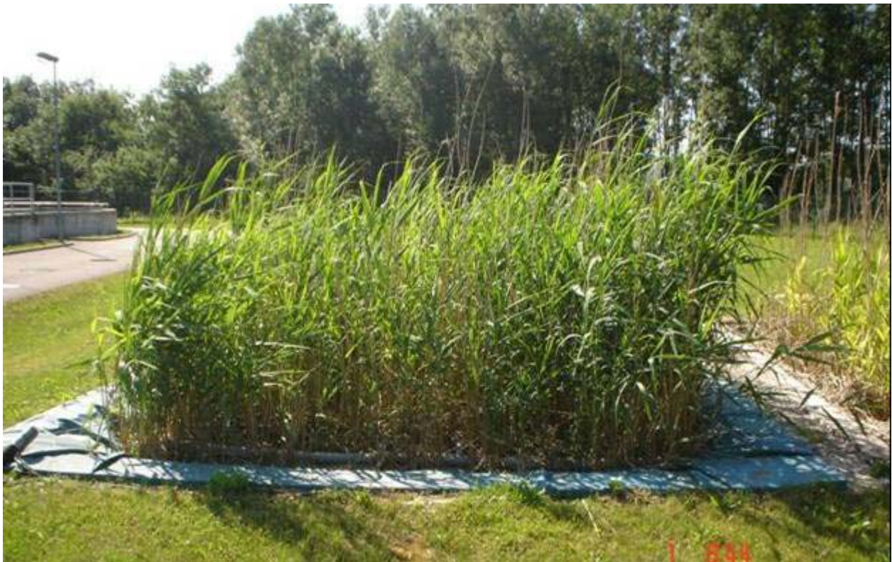
Abbildung 43 Bodenfilter BF3.1 und BF3.2 im Juni 2007
