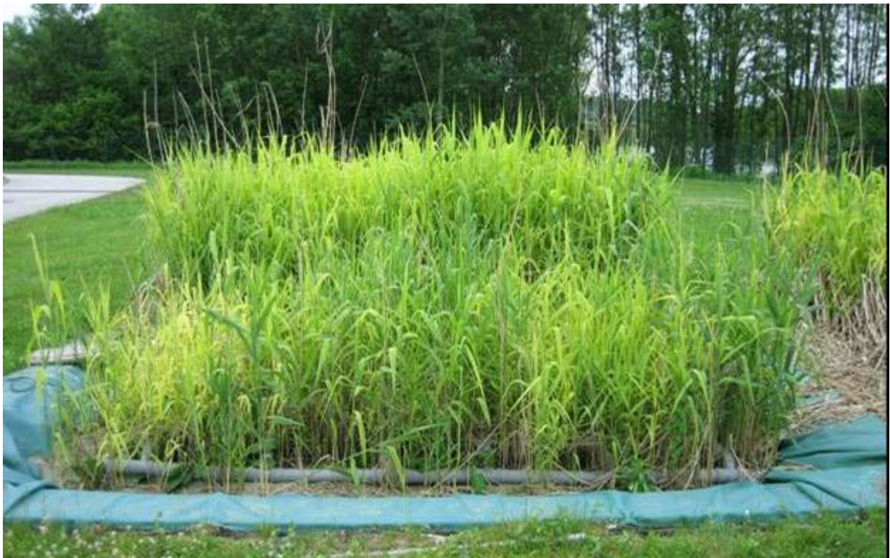
Abbildung 36 Bodenfilter BF3.1 und BF3.2 im Mai 2006
