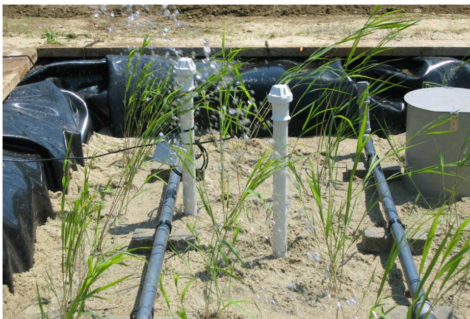
Abbildung 46 Beschickungsnaher und -ferner Einbau der Sonden.
