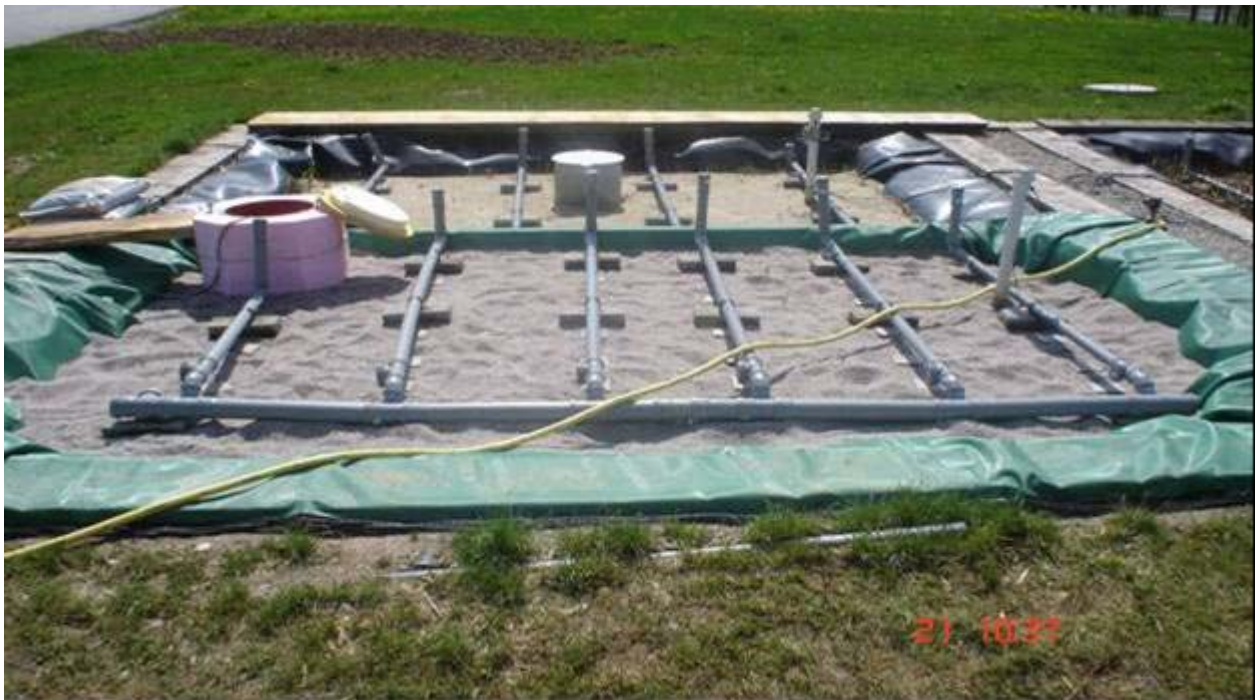
Abbildung 31 Bodenfilter BF3.1 und BF3.2 während der Errichtung im April 2005
