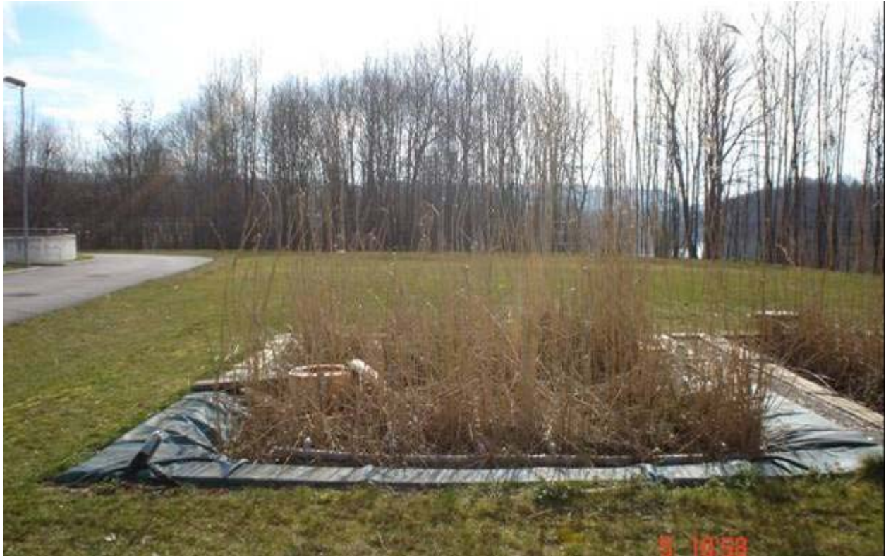
Abbildung 41 Bodenfilter BF3.1 und BF3.2 im März 2007
