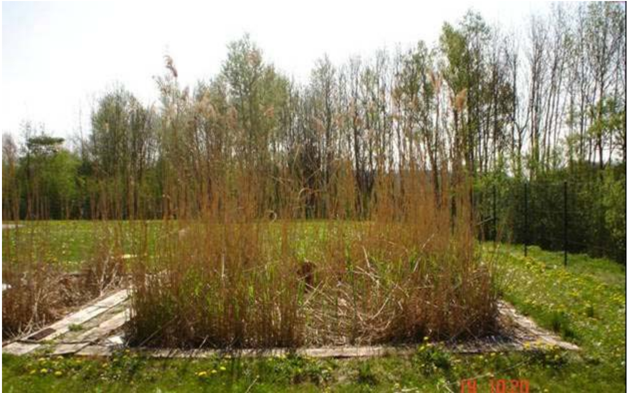
Abbildung 27 Bodenfilter BF1 im April 2007
