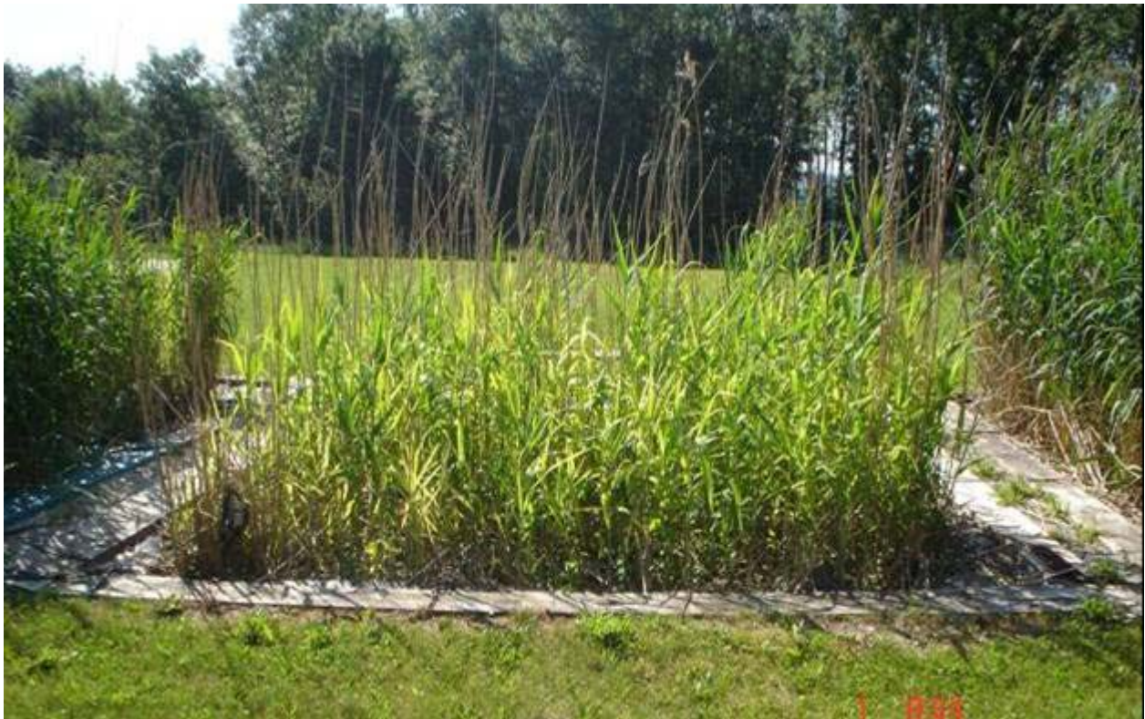
Abbildung 30 Bodenfilter BF2 im Juni 2007
