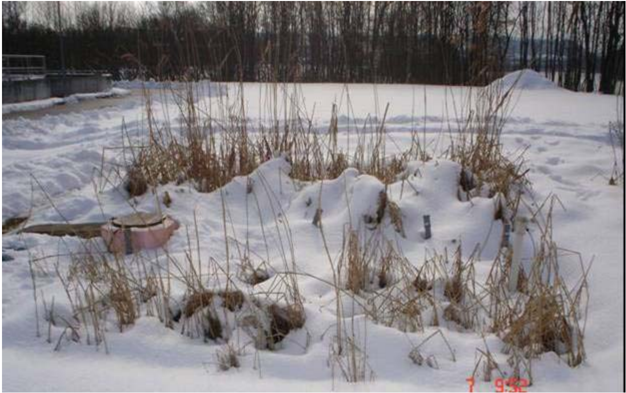
Abbildung 35 Bodenfilter BF3.1 und BF3.2 im März 2006
