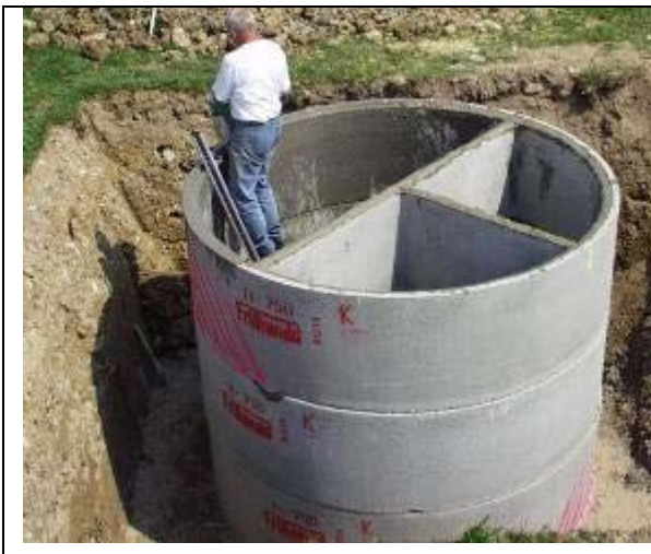
Abbildung 2 Errichtung der 3-Kammer-Anlage
